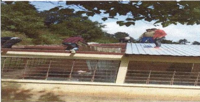
Foto1: Sustitución de lamina, por lamina troquelada aluzincn calibre 26
